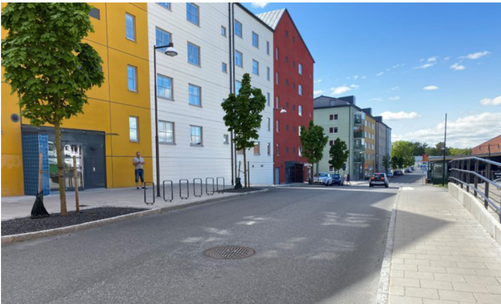
Exempel på gata med en nivå som motsvarar utökad, Chamottevägen, Gustavsberg. Foto Nacka kommun
