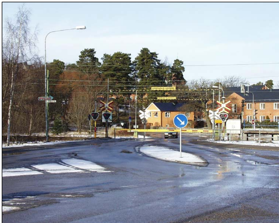
Figur 2 Ringvägens korsning med Hotellvägen. Järnvägsövergången i bakgrunden.
