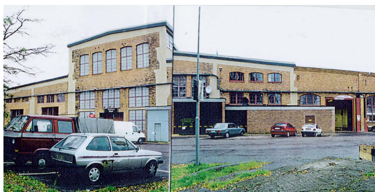
201-202 Montering och maskinverkstad (nuvarande Dieselverkstaden och Astoria)
