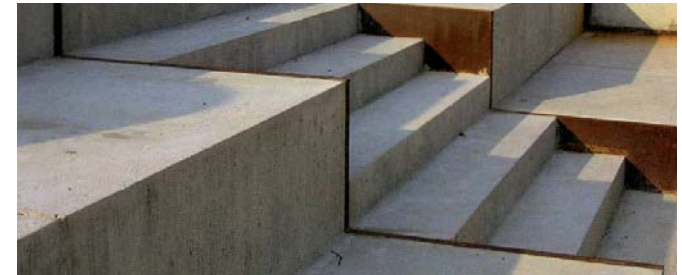
Platsgjuten betongtrappa med kantstöd av corténplåt
