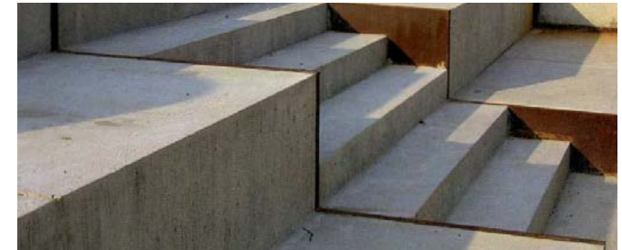
Platsgjuten betongtrappa med kantstöd av corténplåt
