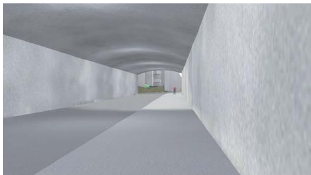
2, mitt i tunneln.
