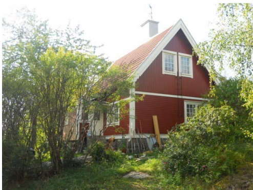
Vaktmästarbostaden strax norr om huvudbyggnaden. (Byggnad nummer 7)
