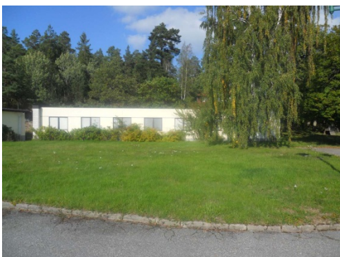
Förlägningsbyggnaden norr om gästhemmet. (Byggnad nummer 10)
