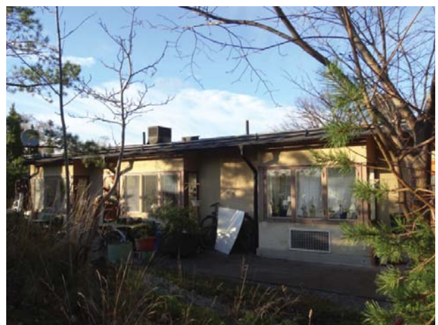
Butikshusets baksida med indragna uteplatser och burspråksliknande fönsterpartier för lägenheterna. Utformningen påminner om radhusens söderfasader med indragna uteplatser. Delar av denna fasad ska kopplas ihop med en ny byggnadsvolym inrymmande förskola. Det är då viktigt att återstående delar behåller sin karaktär.
