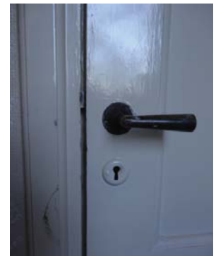
Dörrfoder, trycke och nyckelskylt av 1930-talstyp. Det nätta fodret har en liten profilering utmed ytterkanterna. I snickeridetaljerna har funktionalismen ännu inte blommat ut, vilket kan berätta om att huset befinner sig i ett arkitektoniskt brytningskede.
