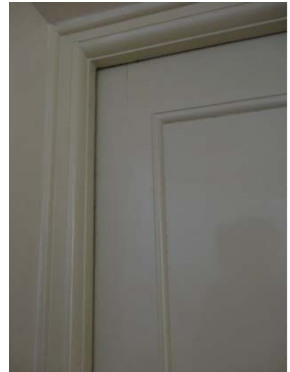
Mjukt formade profiler på dörrkarm och dörrspegel.
