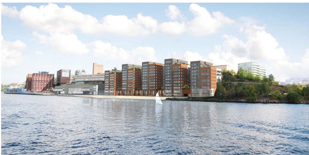
Norrhusen, nordvästra kajen, vy mot sydost
