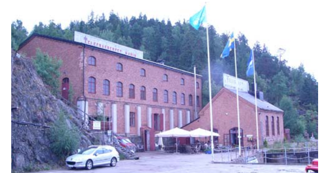
Befintliga tegelhus på kajen
