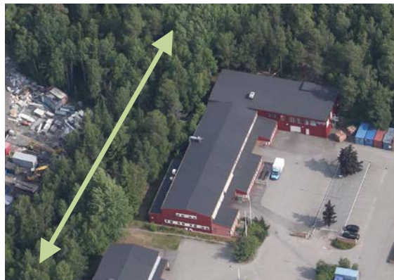
Grönt släpp till vänster, uppställningsyta till höger om byggnaden.
