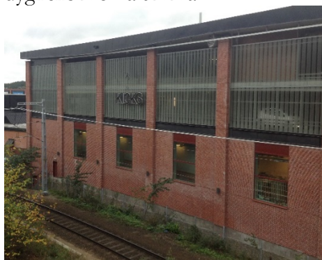
Material och utförande på Sickla galleria etapp II, fasad mot Saltsjöbanan
