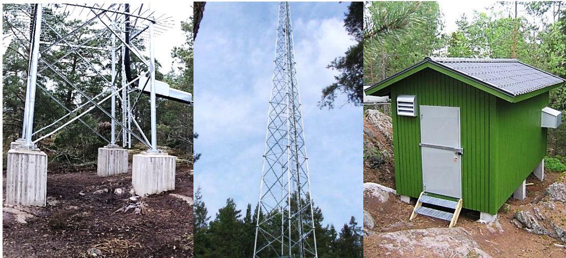
Bild till vänster visar exempel på mastfundament. Bild i mitten visar mobilmast i den masttyp som avses att uppföras. Bild till höger visar utformning av teknikbodarna som verksamhetsutövaren avser att uppföra. (bildkälla: Hi3G)
