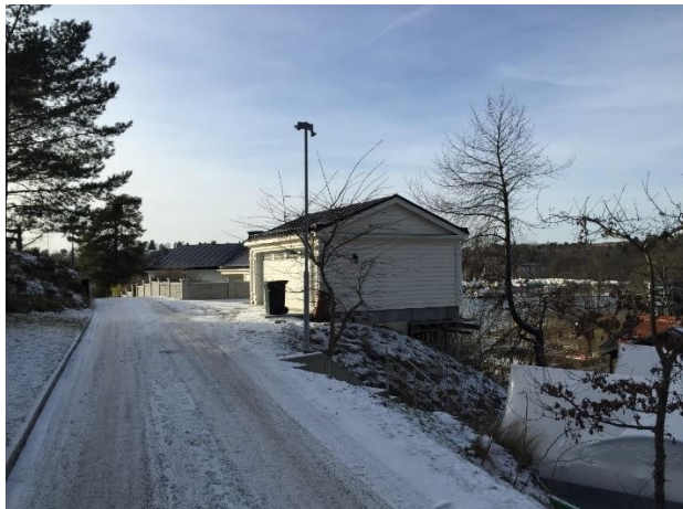
Vy över garage från Korsuddsvägen (syd)
