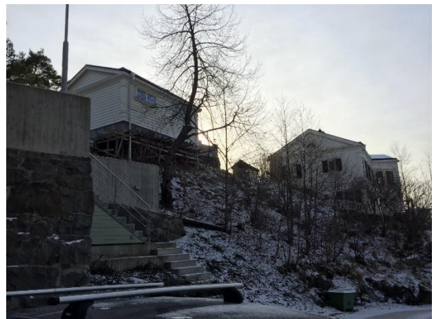
Vy över garage från Korsuddsvägen (nord)
