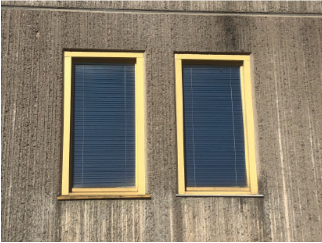
Accentfärger runt fönsterkarmar på befintlig bebyggelse.
