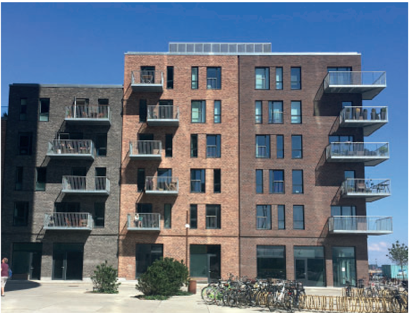
Referensbild: skarvar som medveten gestaltning samt balkonger.
