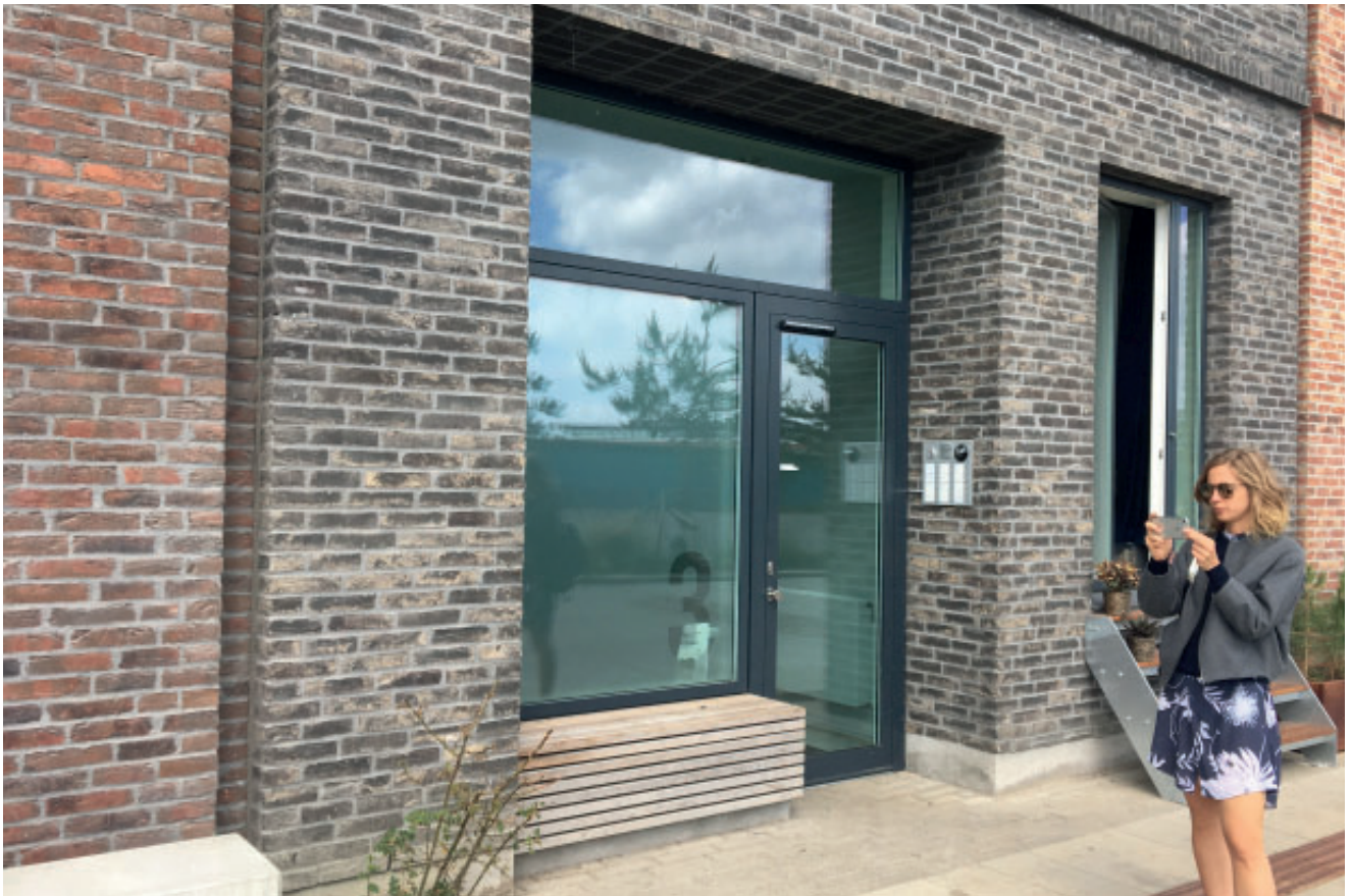
Referensbild: bostadsentré som är indragen från gata.
