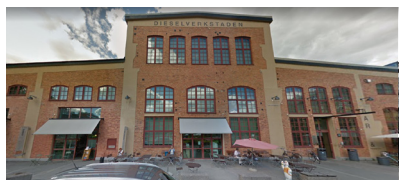
Befintlig fasad - Monteringshall fasad mot Marcusplatsen
