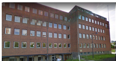
Befintlig fasad - Huvud kontor fasad mot Järnvägsgatan
