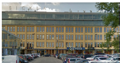
Befintlig fasad - Lufts-verkstad fasad mot Smedjegatan
