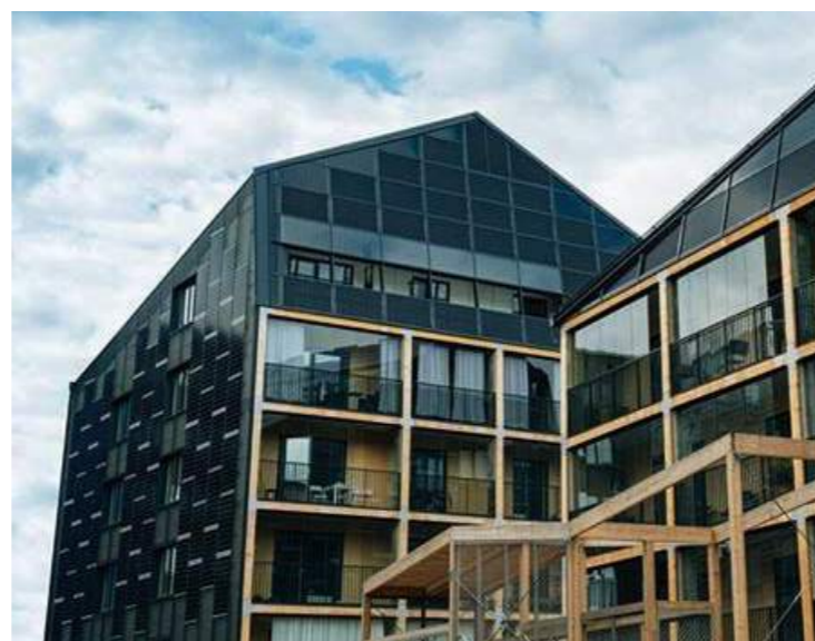
Backåkra, Stockholmshem, Norra Djurgårdsstaden - solceller på fasader
