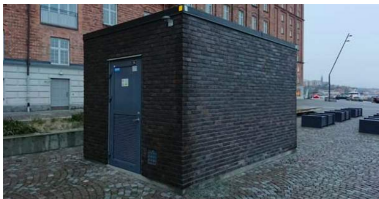
Exempel på nätstation i tegel.
