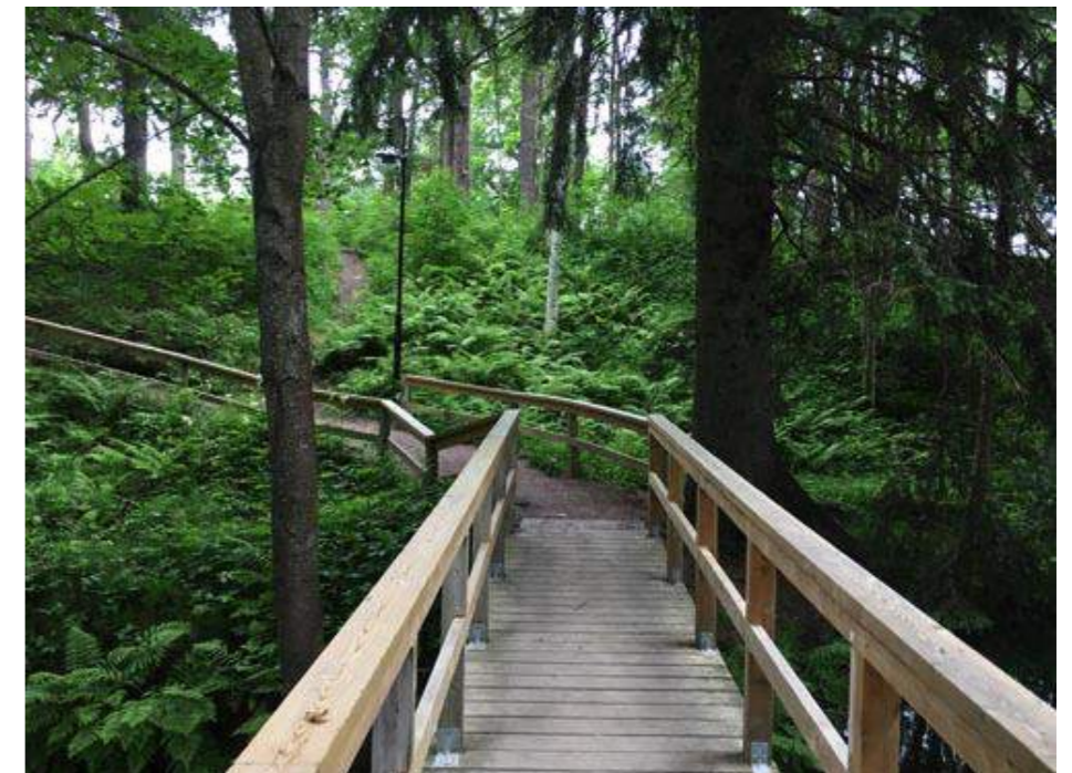
Träkonstruktion för att ta upp höjdskillnad
