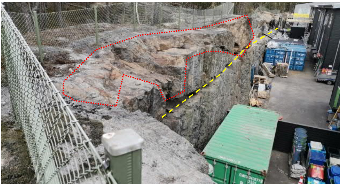
Figur 5 – Bergskärning vid fastighet Älta 10:34. Foto taget mot VNV från delområde 1 (södra).
