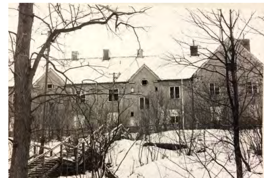
tidigare bostadsbyggnad, nu riven
