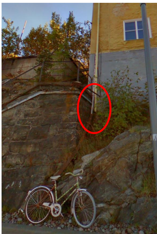
Figur 6. Ytlig avledning av takdagvatten i husets nordöstra hörn.
