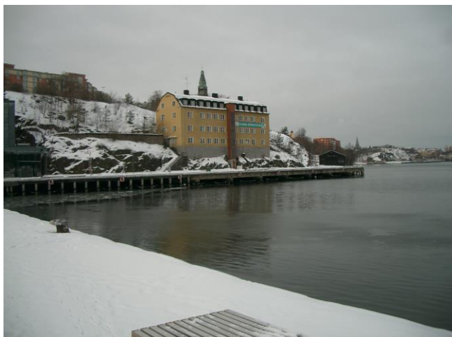
Figur 3. Vy från piren in mot byggnaden på fastigheten Sicklaön 37:46.
