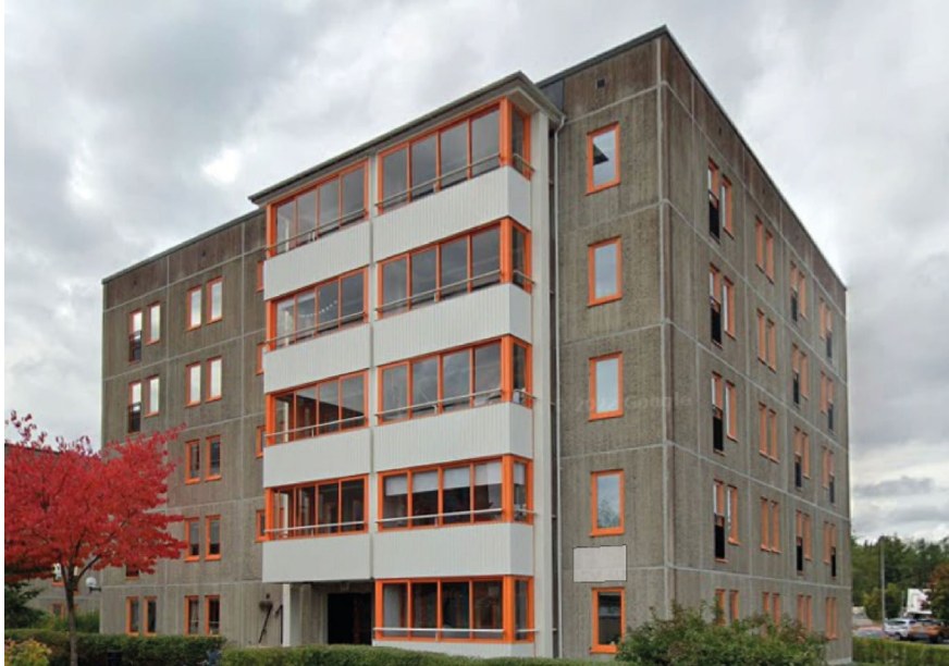
Figur 5 Befintlig bebyggelse med god terränganpassning och färgacenter enligt Ormingepaletten. (Nacka kommun, 2024)
