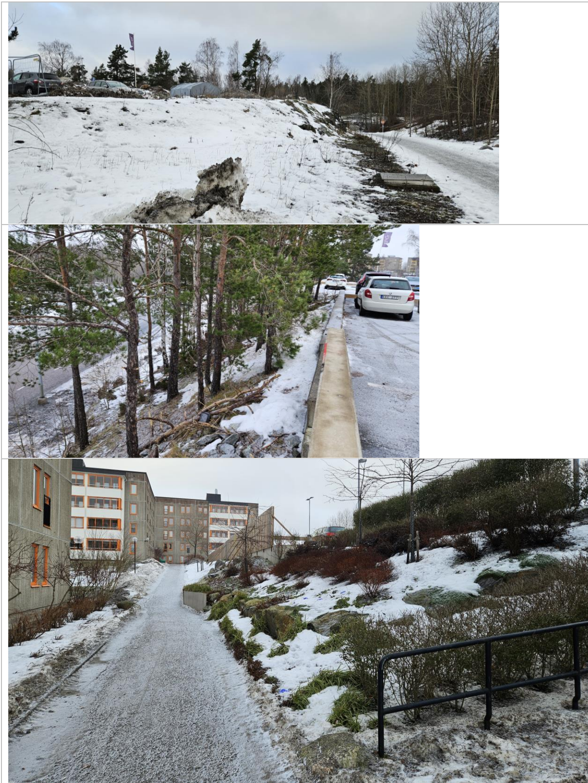
Figur 3.3. Foto från platsbesök 2024-01-25. Överst: I nordvästlig riktning vid den genomskärande GC-vägen och kanten av parkeringen inom fastigheten 37:2. Mitten: Kanten av parkeringen vid Ormingeringen. Underst: Gångväg mellan hus och parkering för fastigheten 37:2.
