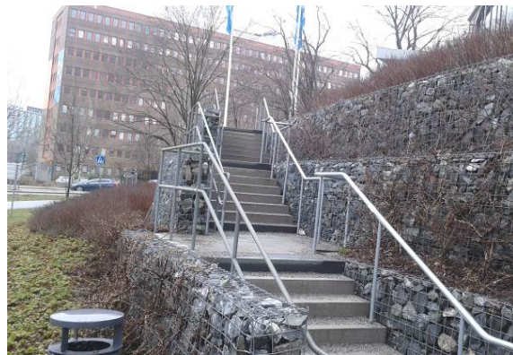
Trappa upp till Atlas Copcos entré från Järlaleden.
