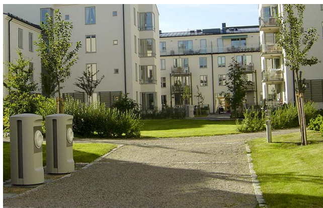
Stationär sopsug i Norra Hammarbyhamnen, Stockholm. Källa Envac
