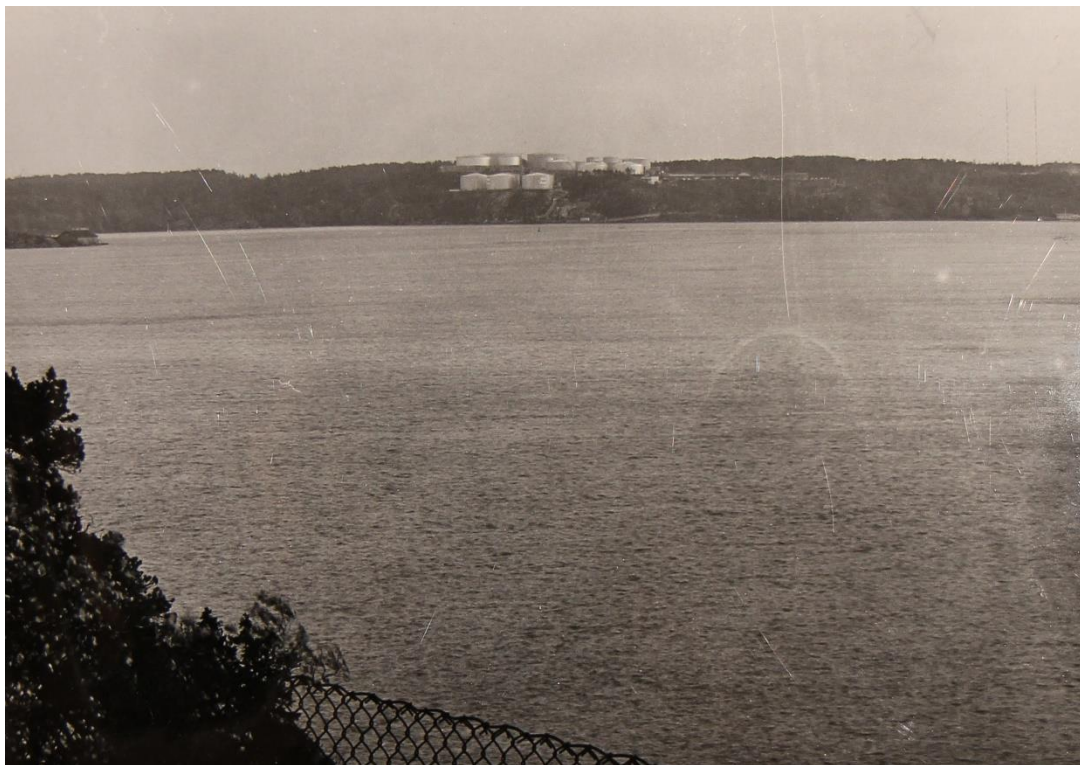
Bergs oljehamn. Fotografi taget av Tore Ahlsén på uppdrag av Arkitekturmuseet 1968. Källa: ArkDes ritningsarkiv.
