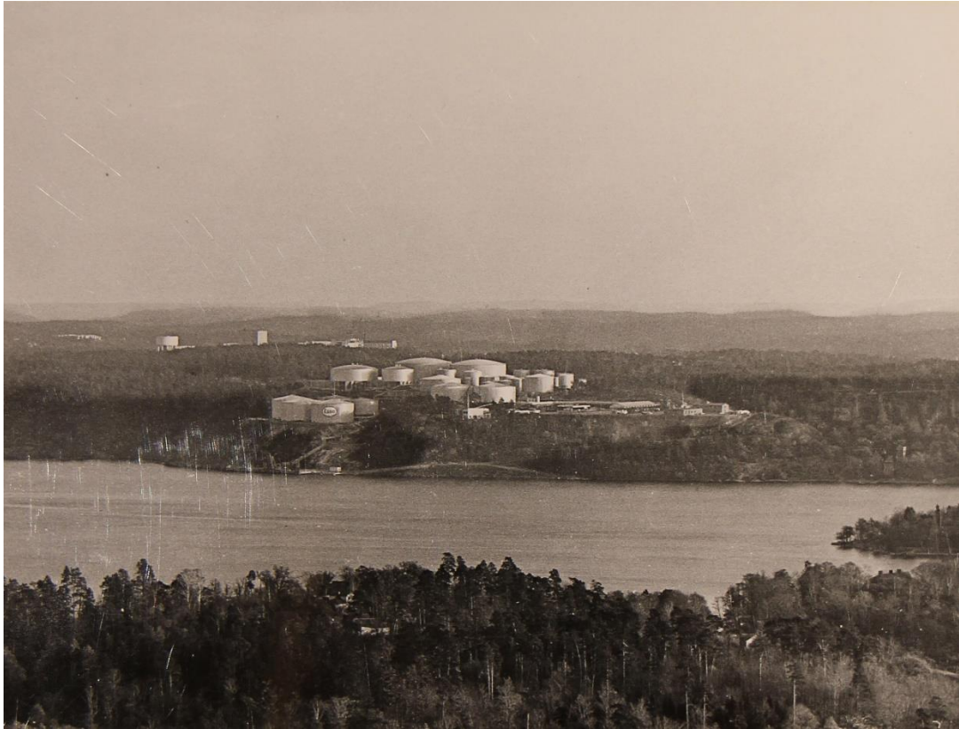
Bergs oljehamn. Fotografi taget av Tore Ahlsén på uppdrag av Arkitekturmuseet 1968. Källa: ArkDes ritningsarkiv.
