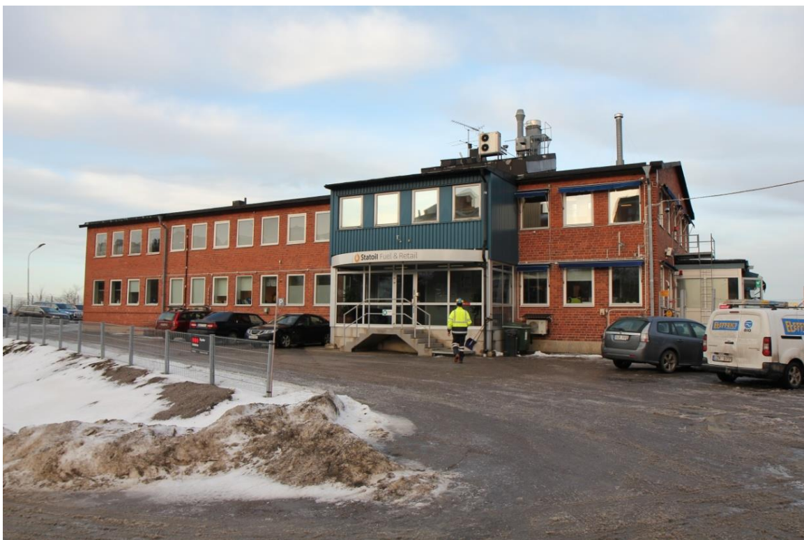
Kontorsbyggnaden, fotografi från januari 2017
