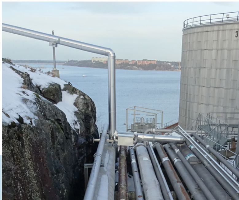
Mellanrum mellan cisterner, pipelines och andra byggda strukturer ramar in blickfång.
