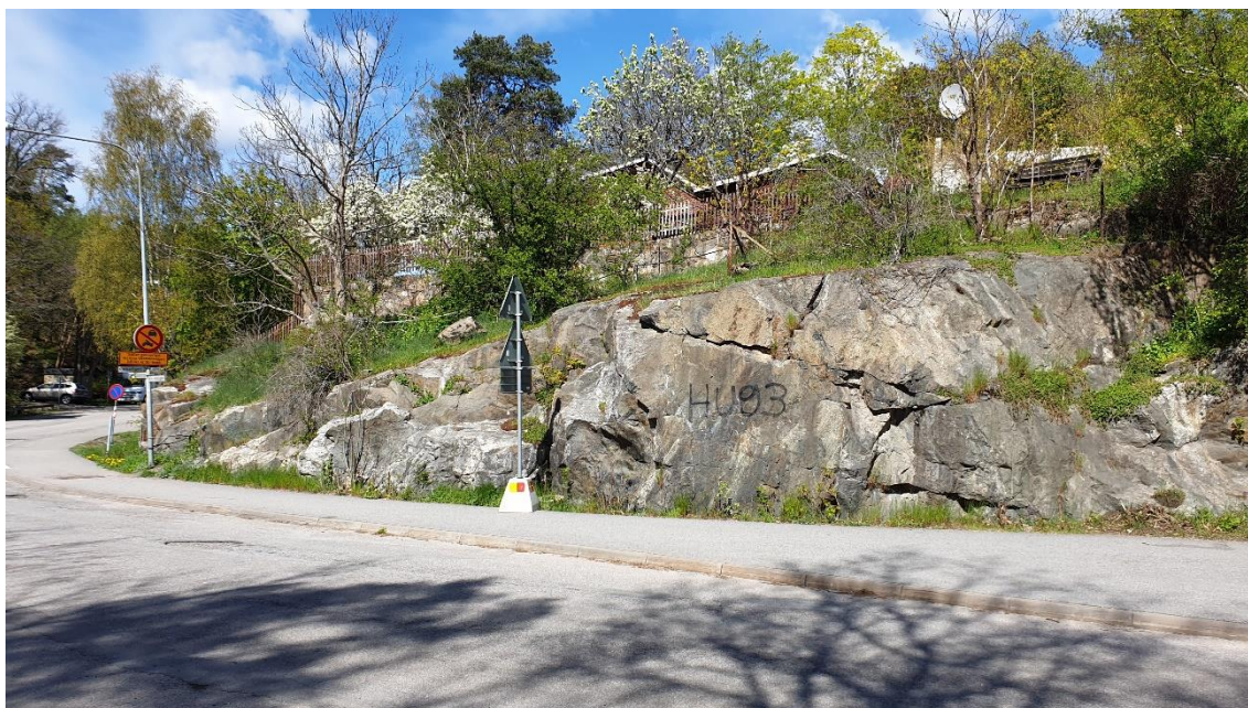
Figur 4. Bild av bergskärningen i kvarter Birkavägen.
