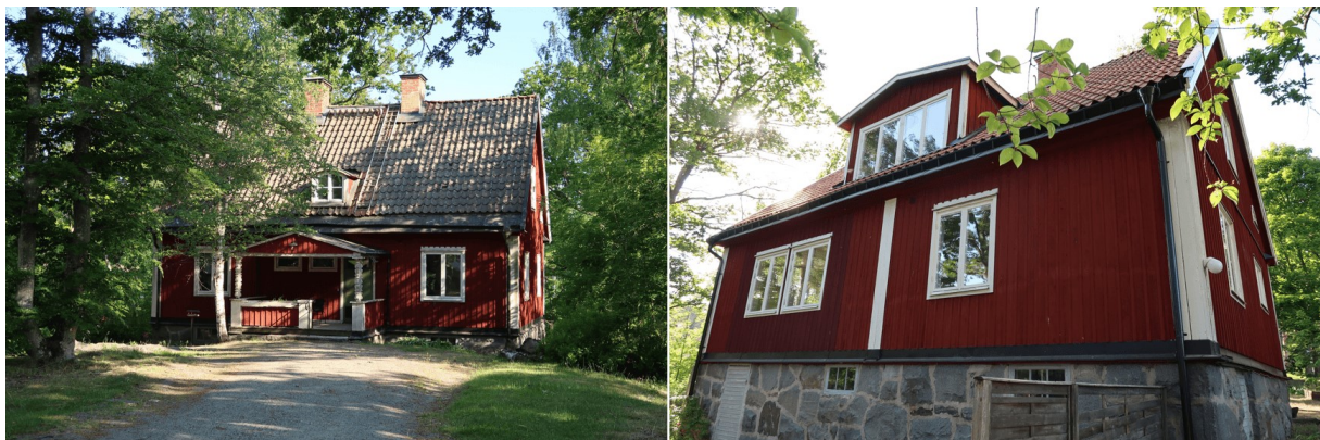
Figur 7: Till vänster rektorsvillans framsida med öppna verandan med profilerade pelare samt den lilla takkupan. Till höger baksidan med hög grund av tuktad fogad natursten och källardörr. Bildkälla: Nacka kommun.
