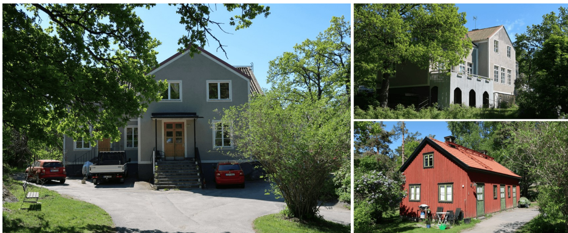
Figur 4: Till vänster och uppe till höger före detta församlingshemmet med skarpa skurna former och brutna vita putsade detaljer. Nere till höger komplementbyggnaden med röd locklistpanel och gröna snickerier. Bildkälla: Nacka kommun.
