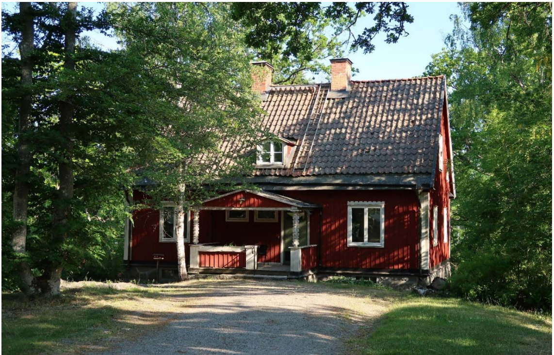
Fasaden mot norr.
