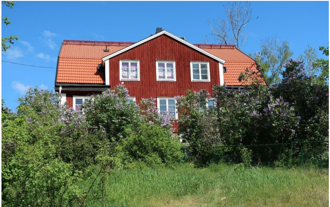
Byggnaden sedd från gång- och cykelvägen i söder.
