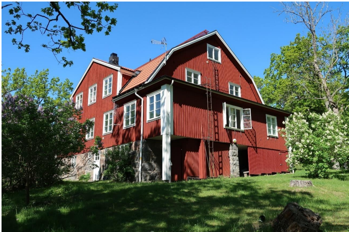
Mot söder har byggnaden en hög och välbyggd sockel med källarvåning, vy från sydost.
