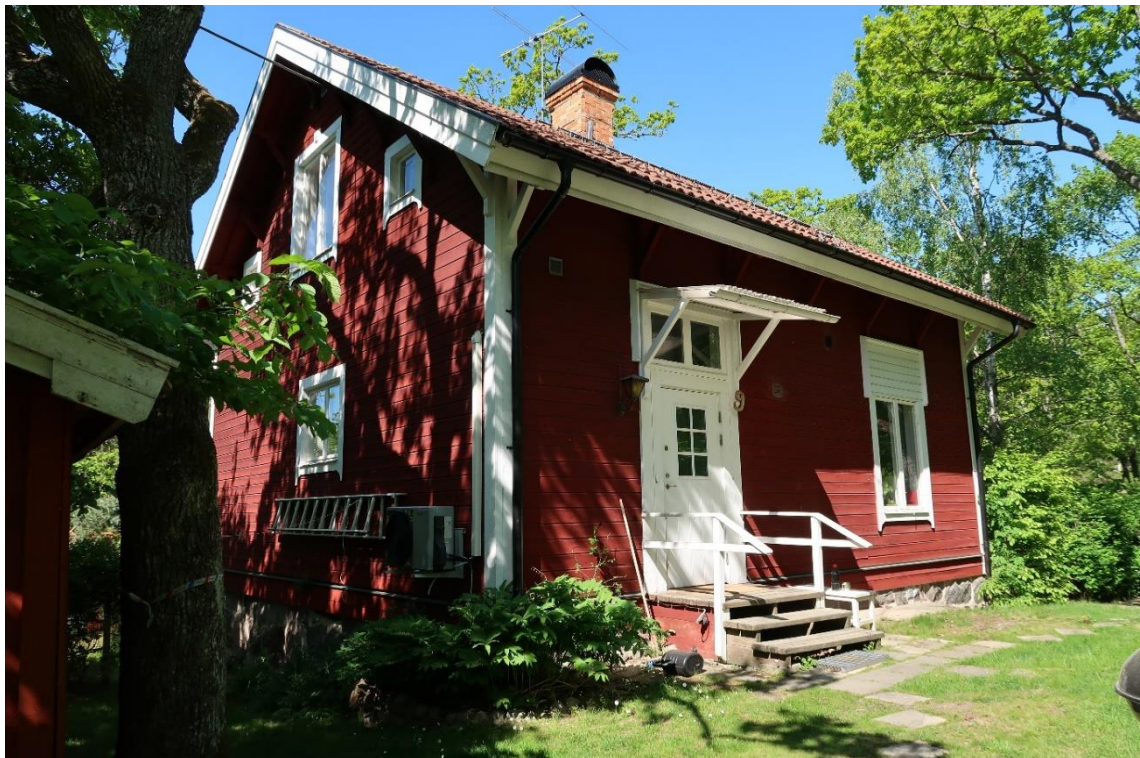
Byggnadens entréfasad mot öster.
