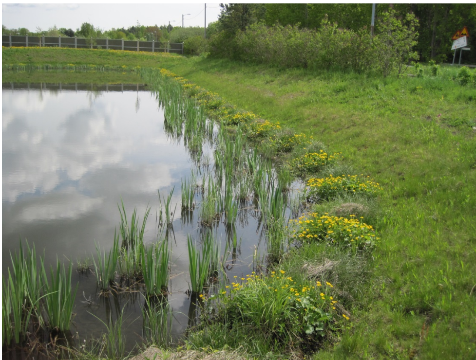
Figur 13, strandmatta skapar möjlighet för snabb etablering av vegetation i strandzonen. Foto Veg Tech AB.
