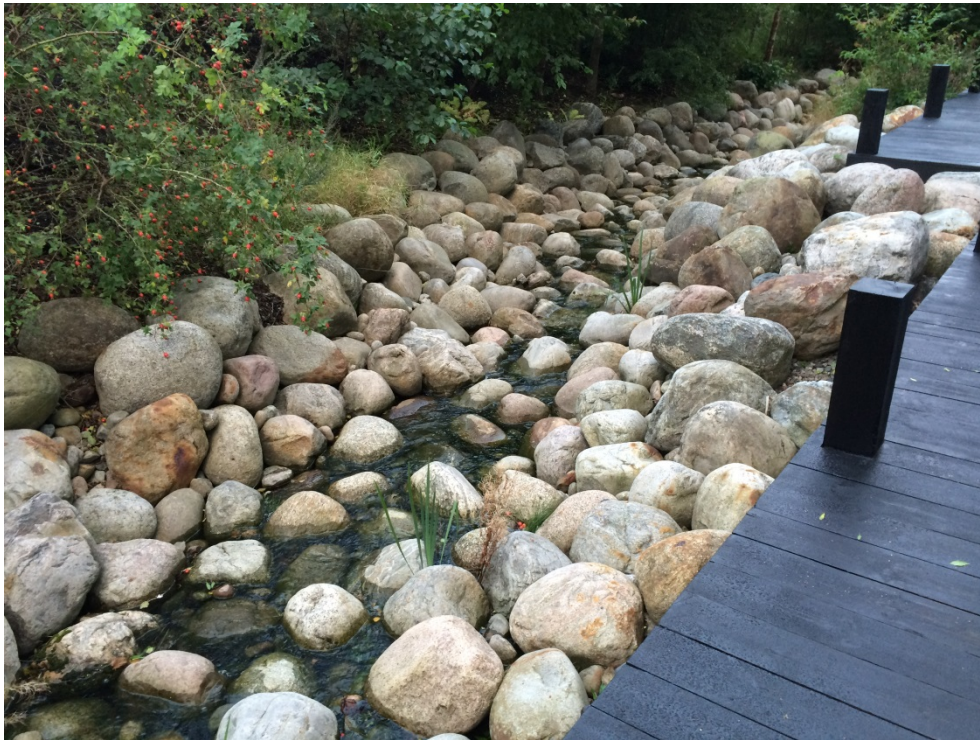
Figur 6, exempel utformning av vattendrag, anpassat för olika vattennivåer.
