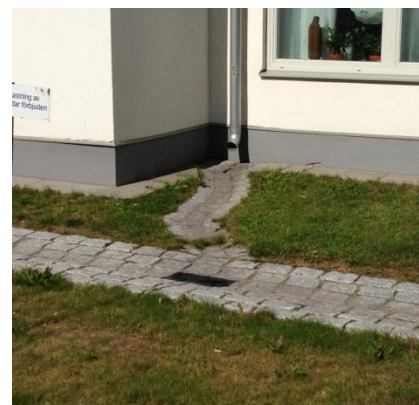
Figur 9. Utkastare med ytlig avledning
