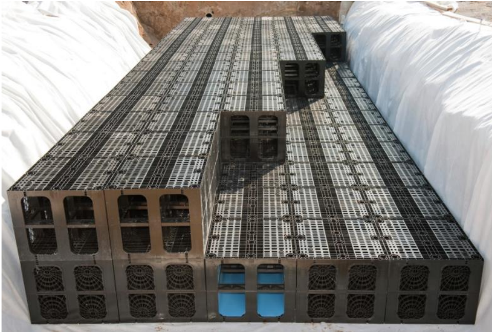
Figur 5. Exempelbild på dagvattenkassetter och hur dessa strategiskt kan placeras vid platsspecifika behov.
