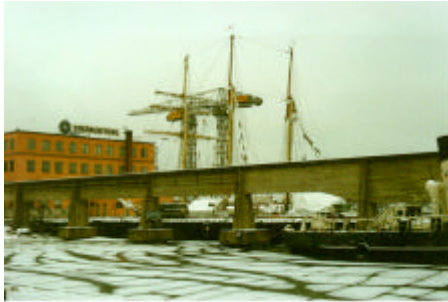
Vy längs kajen mot Strängbetongs byggnad
