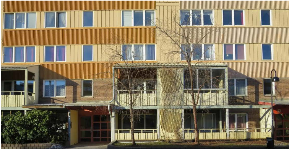
Byggnaderna har en-, två- och trelufts-fönster
