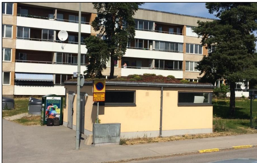
Figur 5-5. Exempel på grönt tak på ett sopsorteringshus i Östberga (Geosigma).
