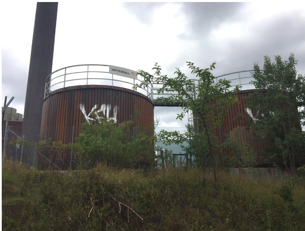
Figur 9. Två utvändiga cisterner om 150 m 3 vardera.
