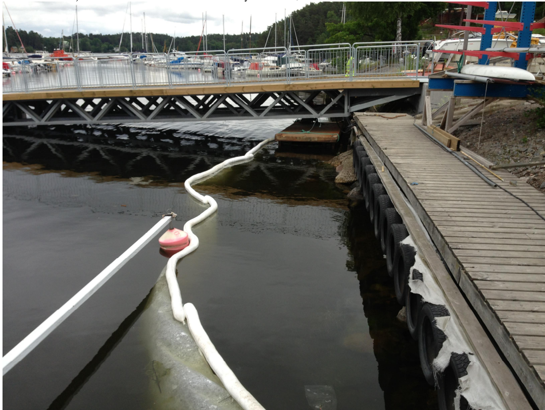
Foto 11: Oljeabsorberande läns och skyddsduk, 2013-06-27
