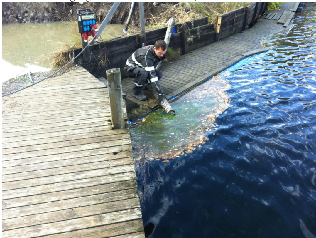
Foto 6: Vacuumsugning av slam från havet mellan oljeläns och ruta 40, 2012-10-16
