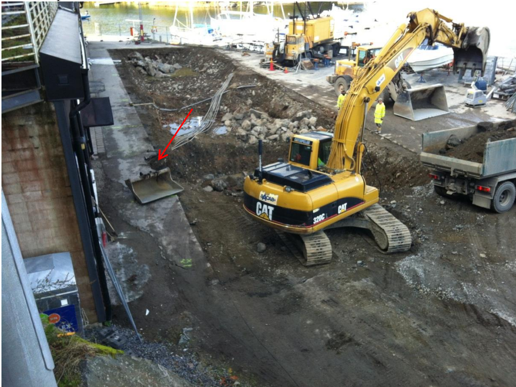
Foto 4: Schaktning av rutorna 6,8,11,14 och 18. Restförorening i ruta 14 är markerad med röd pil, 2012-10-05
