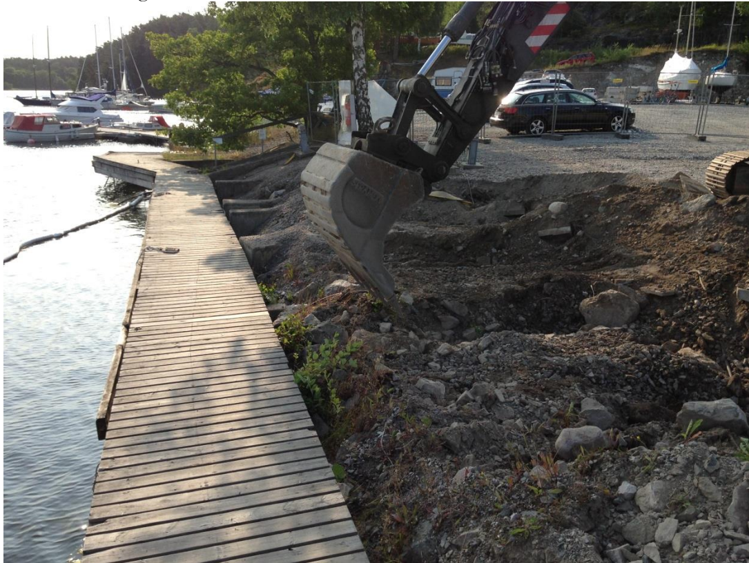
Foto 9: Sanering av ruta 22, 2013-07-08
