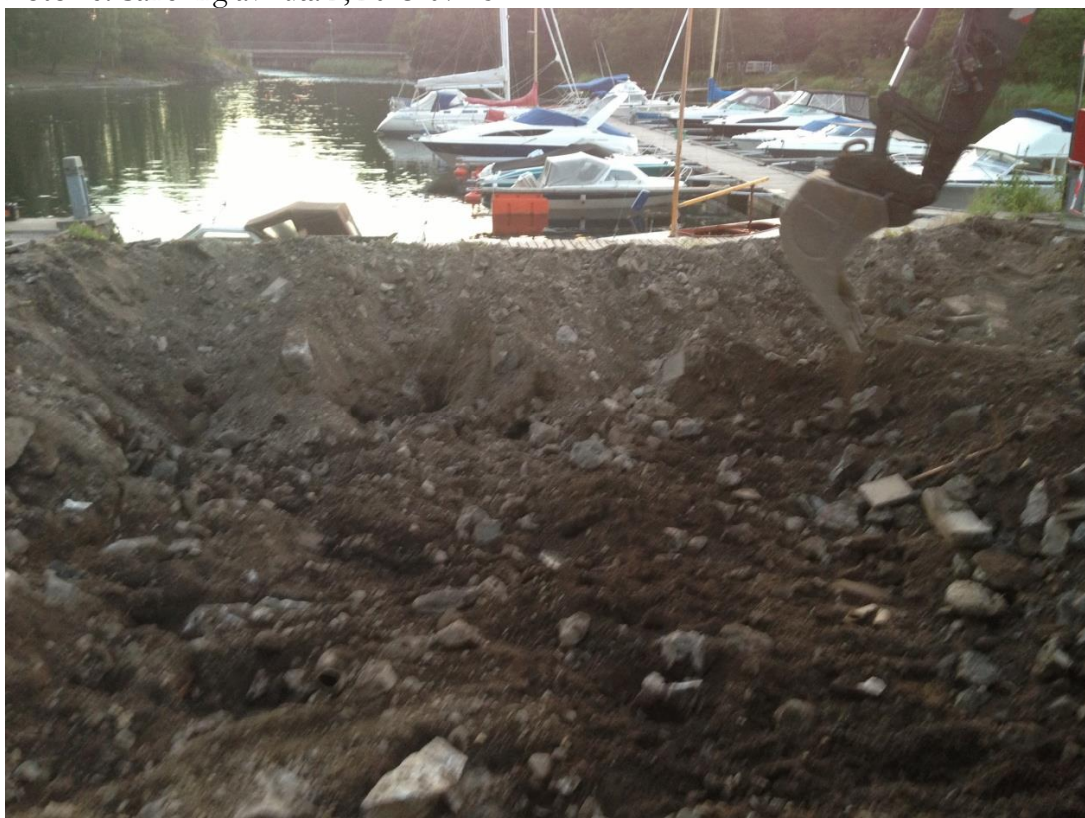
Foto 10: Sanering av ruta 2, 2013-07-15
