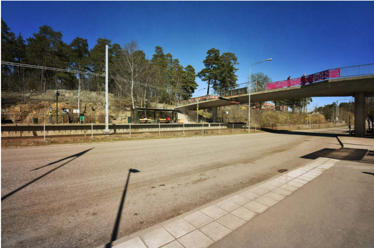
Gångbron förbinder Fisksätra centrum med stationen och naturområdet. Fisksättravägen och spårområdet utgör barriärer. Vy från söder. Foto av Sweco.
