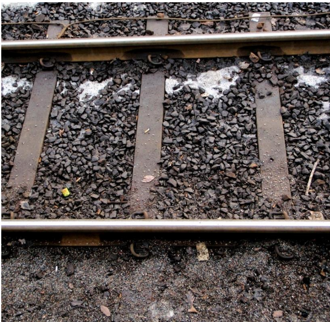
Figur 15. Närbild på spåret. Närmast plattformen, nederst i bilden, syns tydligt en ansamling av grus/sand.
