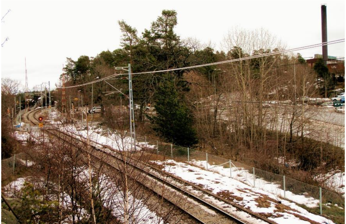
Figur 16. Vy över banvallen i områdets östra del. I nederkant av bild, till höger om spåret, är den ungefärliga placeringen av det planerade teknikhuset.
