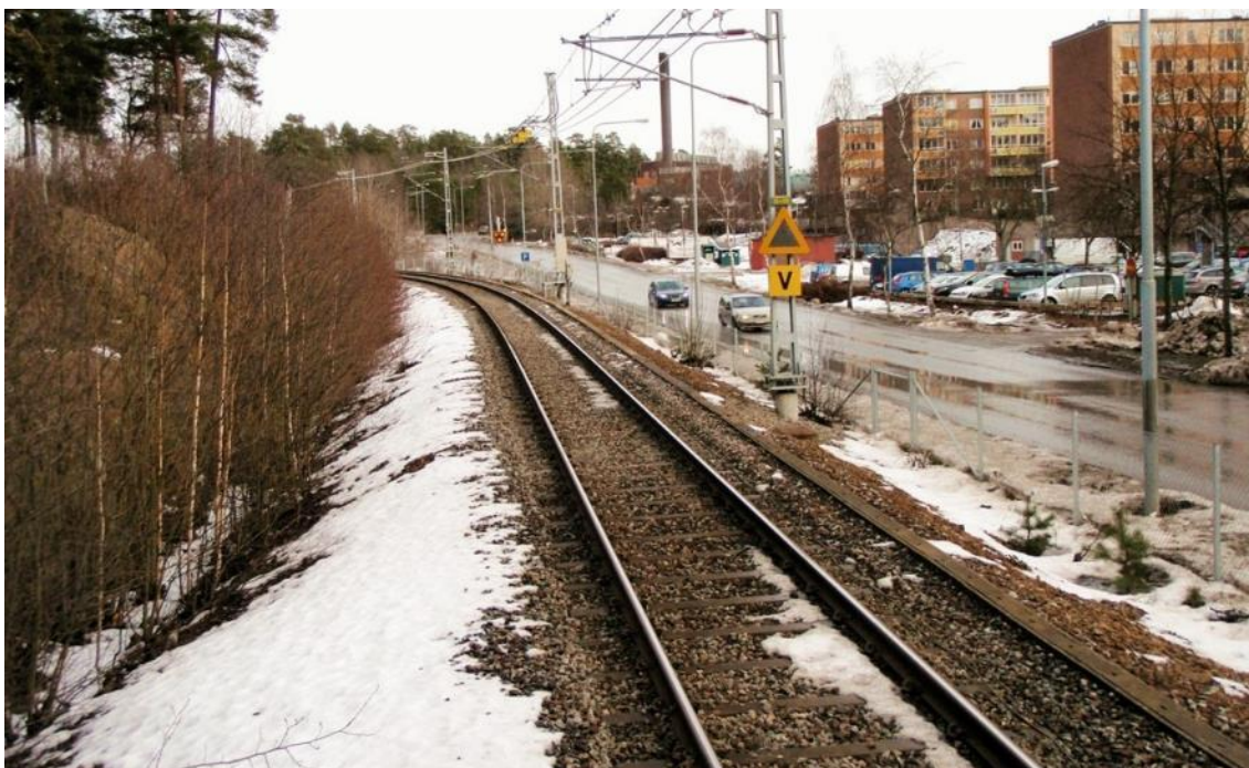
Figur 6. Banvall med enkelspår i östra delen av utredningsområdet. Den har väl tilltagna diken på båda sidor spåret.
