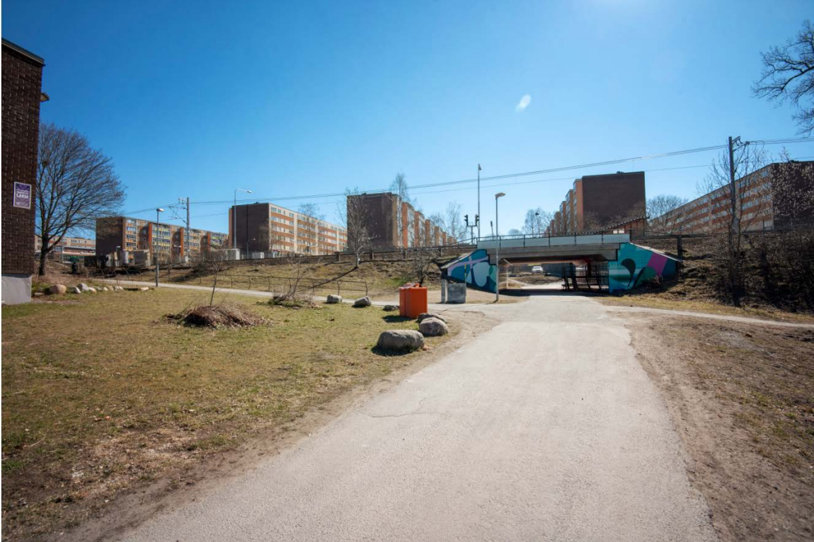
Gång- och cykeltunneln i planområdets västra del kopplar samman områdena norr och söder om Saltsjöbanan. Vy från norr. Foto av Sweco.
