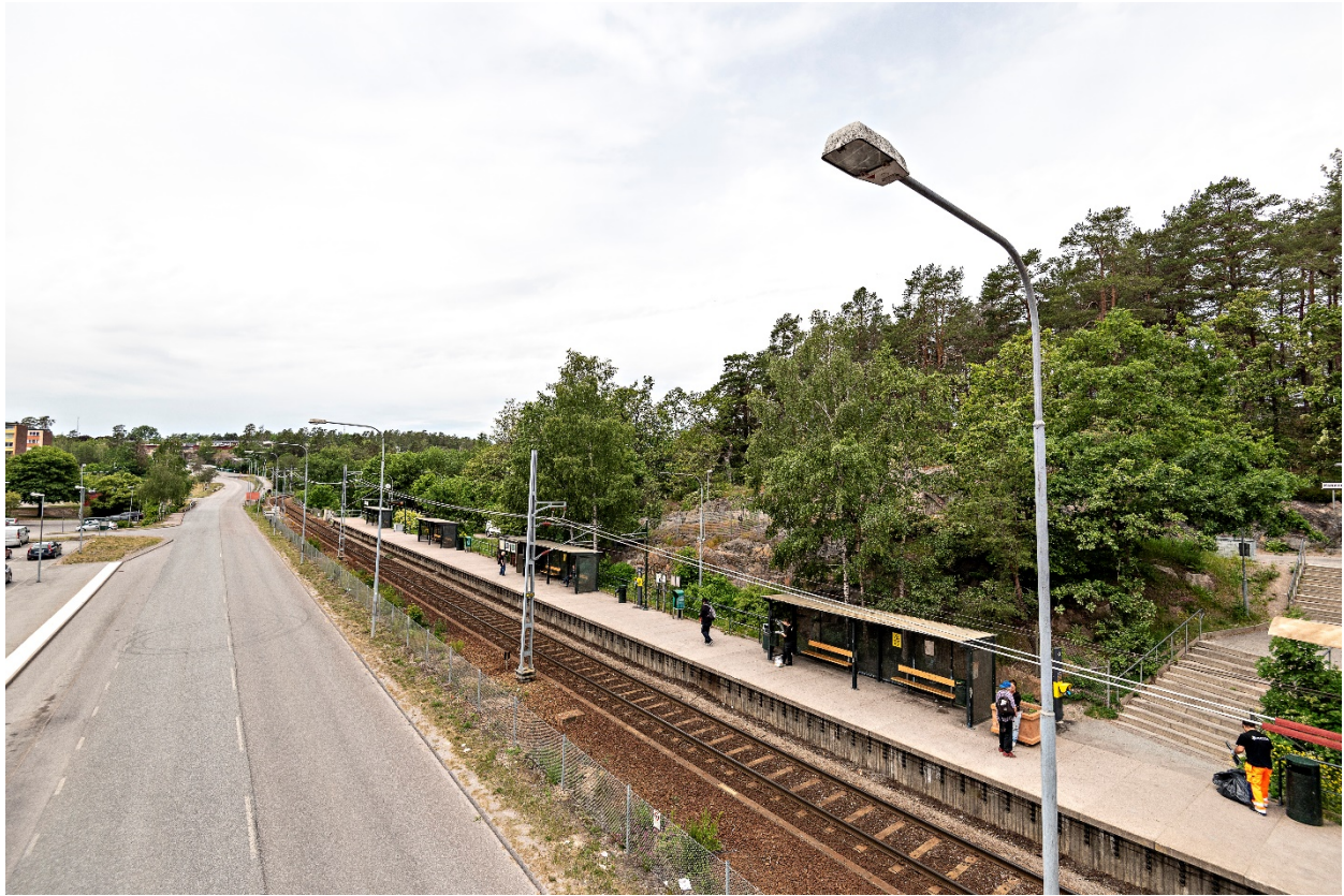
Vy över dagens hållplats från gångbron över Fisksätravägen. Foto: Sweco.
