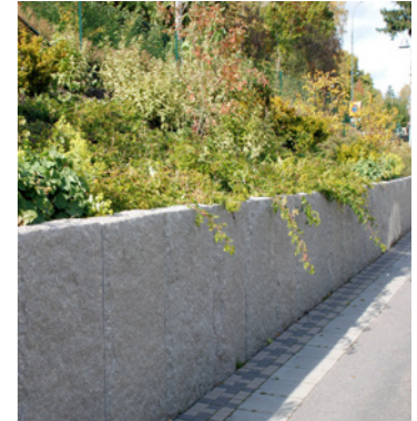
Exempel stödmur i granit / blocksten möte sluttning
