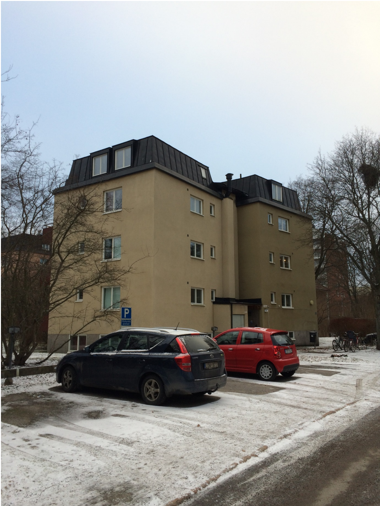
Ursprunglig karaktäristisk takutformning bevaras. Takets plåt kan bytas mot ny lik befintlig.
