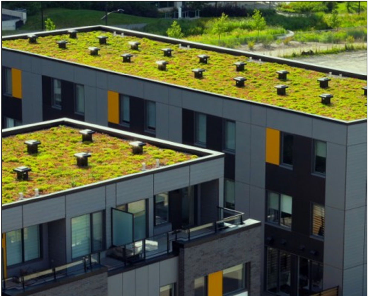
Figur 5-4. Exempelbild på sedumtak i stadsmiljö. Bild: Ljugssedum.
