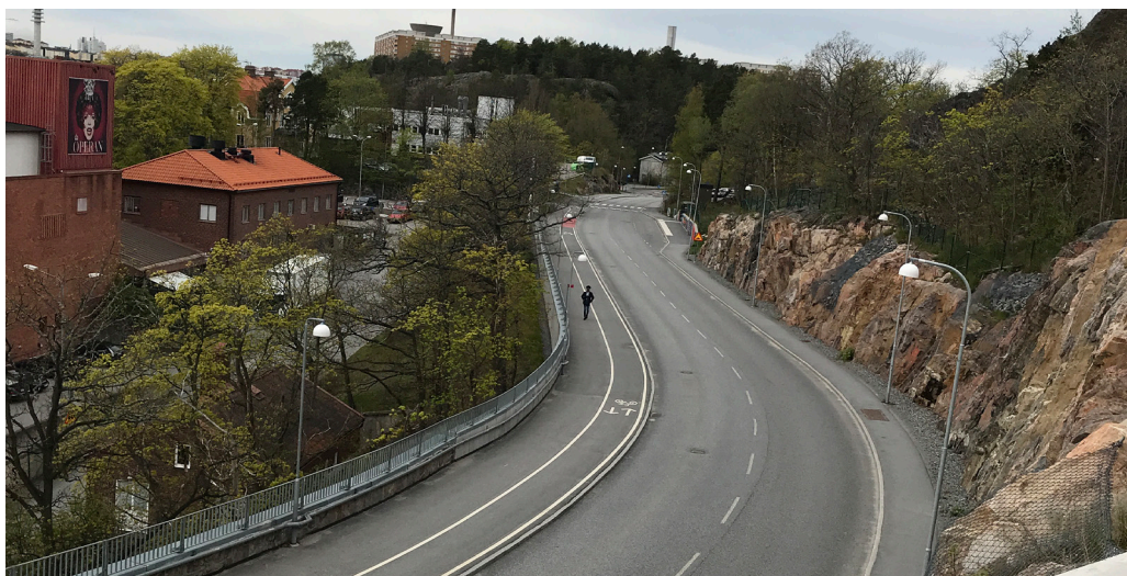
Den nyligen breddade Kvarnholmsvägen skär genom berget på ett brutalt sätt.
