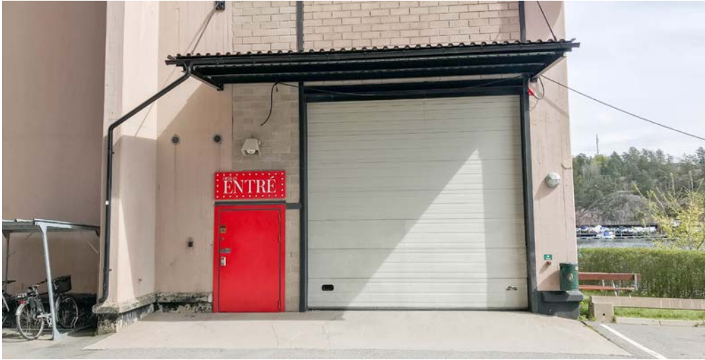
Entrén till den stora repetitionssalen och tidigare föreställningssal är markerad i knall röd färg som kontrasterar mot den gråmålade betongfasaden.
