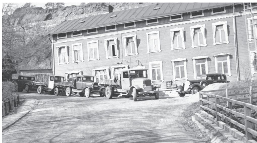
Driftskontoret uppfördes 1872 och låg invid berget där vägen tidigare svängde ner mot infarten till fabriksområdet. Längre upp i bilden syns Kvarnholmsvägen som invidiges 1925. Bolagets huvudkontor låg på Skeppsbron och man hade även ett särskilt försäljningskontor på Stortorget i Gamla Stan. Foto: Gunnar Götherström 1938. Byggnaden revs 1947. Källa: Nackas lokalhistoriska arkiv.
