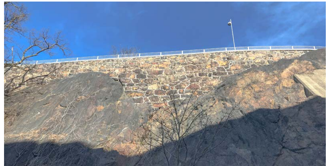
Bevarade delar av Kvarnholmsvägens naturstensklädda vägbanker från 1925.
