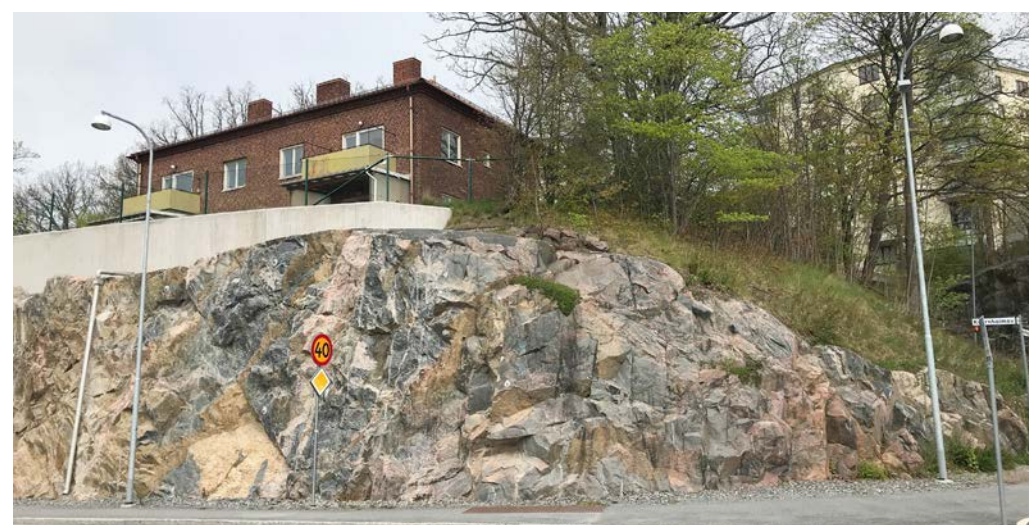
Vid korsningen Kvarnholmsvägen/Finnbergsvägen avslutas de nysprängda bergsyterna med en okänsligt inplacerad mur i gjuten betong. Däröver ligger det f d förmansbostads-huset.
