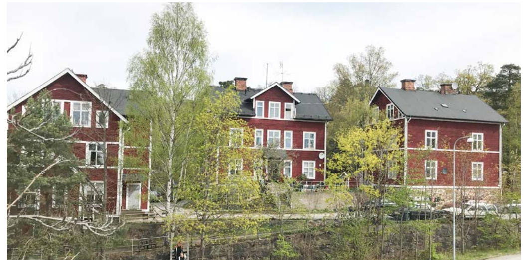
Bevarade arbetarbostäder invid Kvarnholmsvägen. Byggnaderna står på vackra naturstenssocklar och är uppförda i två 1/2 plan med liggande rödmålad panel och vitmålade knutar, foder och listverk. Mot vägen har ursprungliga naturstensmurar bevarats.
