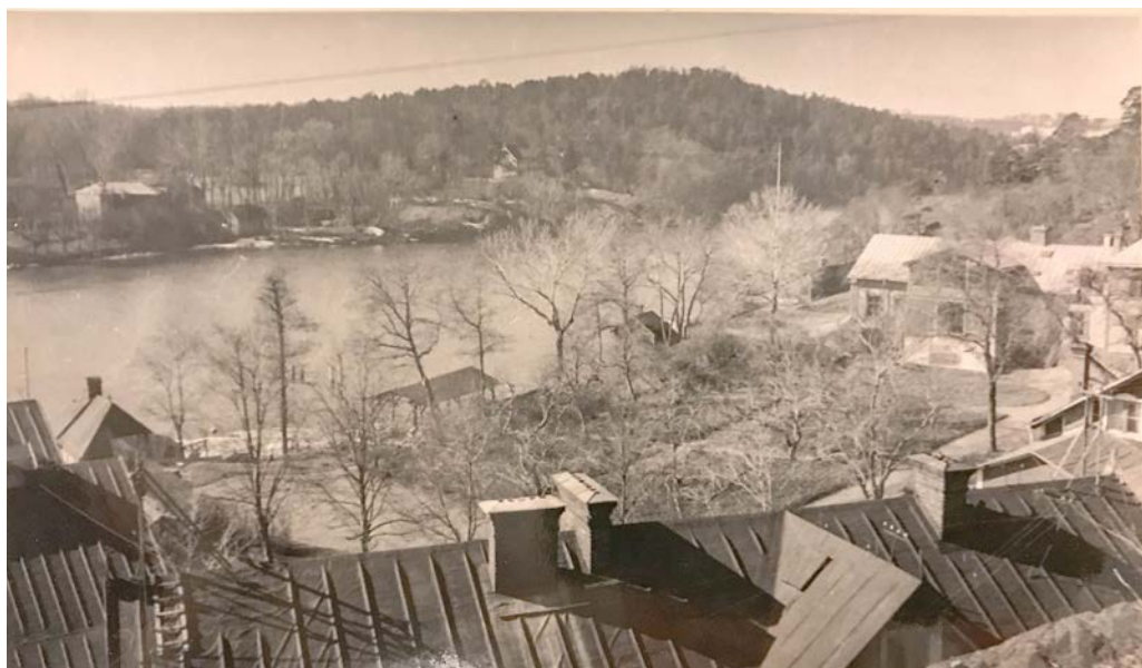
Vy över driftskontorets taknock med direktörsvillan med framförliggande trädgård till vänster. Foto: Gunnar Götherström 1947. Samtliga byggnader revs senare under året. Källa: Nackas lokalhistoriska arkiv.
