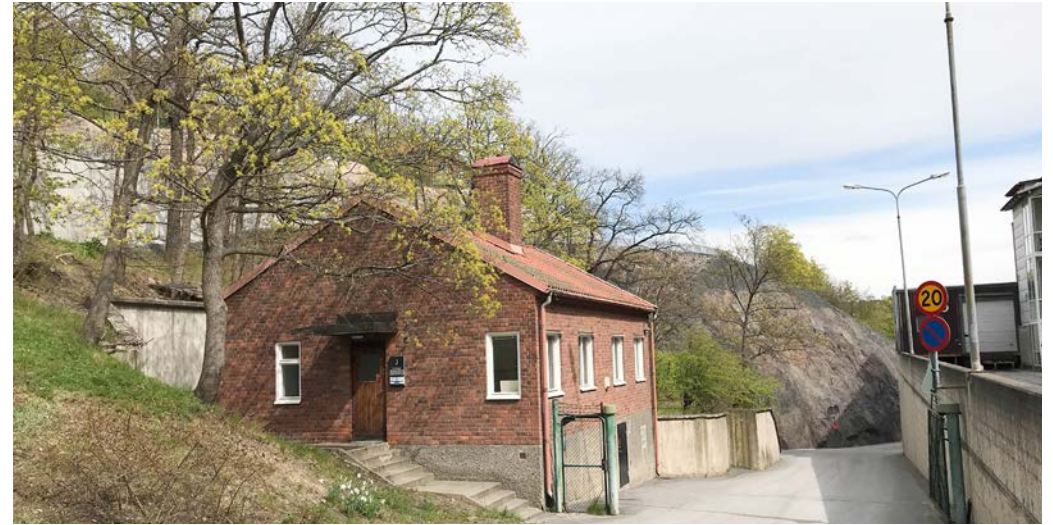
Invid nedfarten till industriområdet ligger en f d portvaktstuga från slutet av 1940-talet. Därbakom syns det karaktärskapande branta bergspartiet som bildar fond i vyn.
