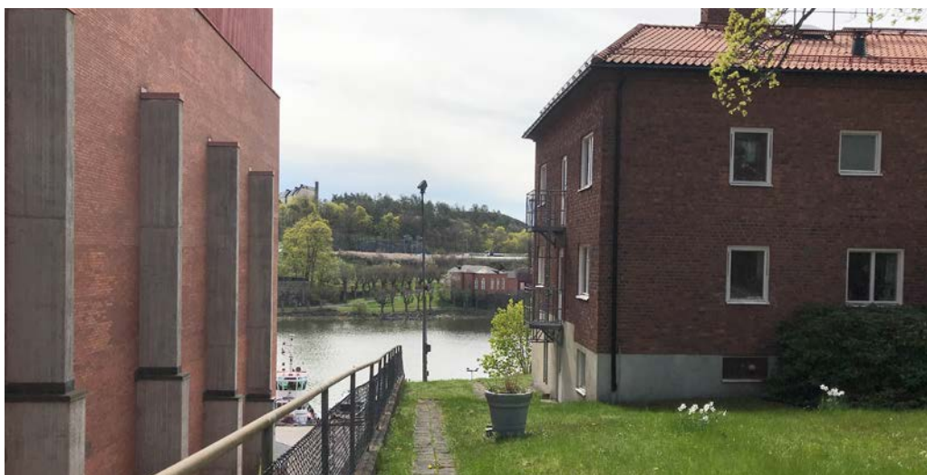
Släpp mellan husen skapar fina utblickar mot vattnet och mot Svindersviks 1700-talsmiljö. Till höger i bild det f d tjänstemannabostadshuset. Skalskillnaden mellan det låga bostadshuset och intilliggande storskaliga industribyggnad skapar en tydlig rumslighet.
