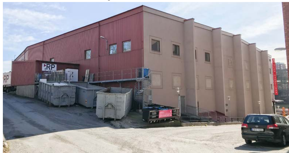
F d maskinhall och korningshus från 1950-talet. Byggnaden hade ursprungligen fasader med synlig betong men har senare klänts in i röd korrugerad plåt och/eller målats. Förändringen har inneburit att byggnadens ursprungliga karaktär med rå betongarkitektur förlorats.
