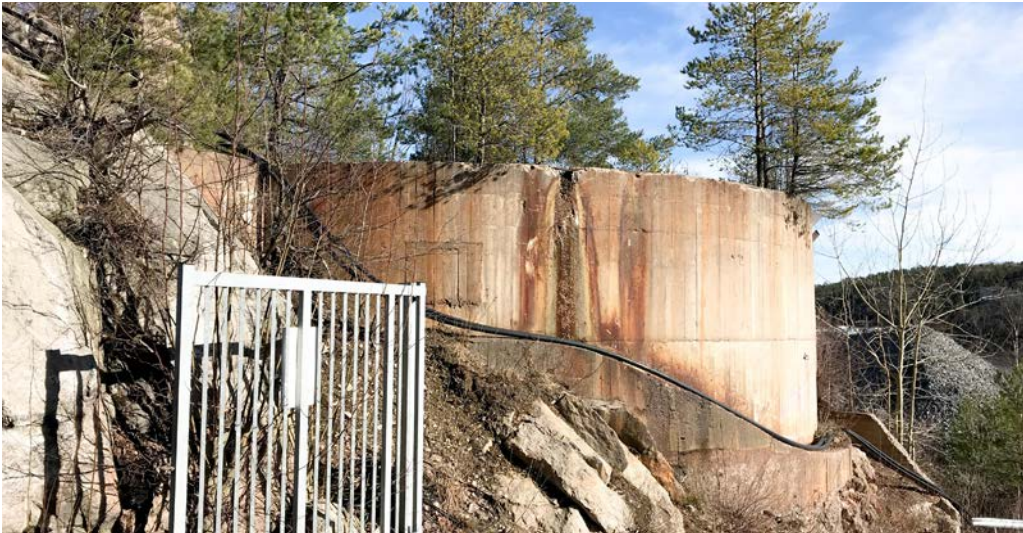
Fundament till en tidigare syracistern som blivit kvar invid berget i områdets sydöstra del.
