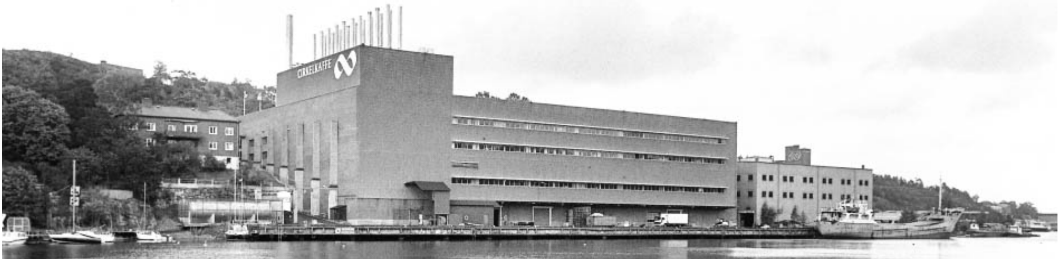
Gäddviken 1994. Kafferosteriets höga, storskaliga volym dominerar vyn och skymmer det bakomliggande berget. Till vänster ligger tjänstemannabostadshuset och till höger maskinhallen/korningsfabriken. Oljecisternerna revs i början av 1990-talet. Fotograf Gerard Asgot. Källa: Nackas digitala arkiv.
