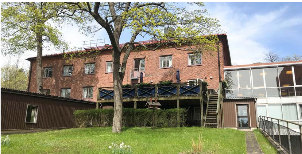
F d kontorshuset med senare tillbyggnader mot trädgården. På den sluttande gräsytan stor en fin lönn.
