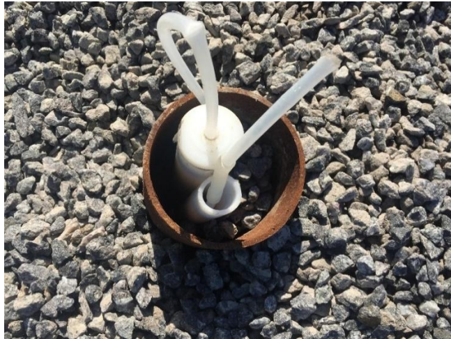
Figur 6-2 Installerade PEH-rör i mark.
