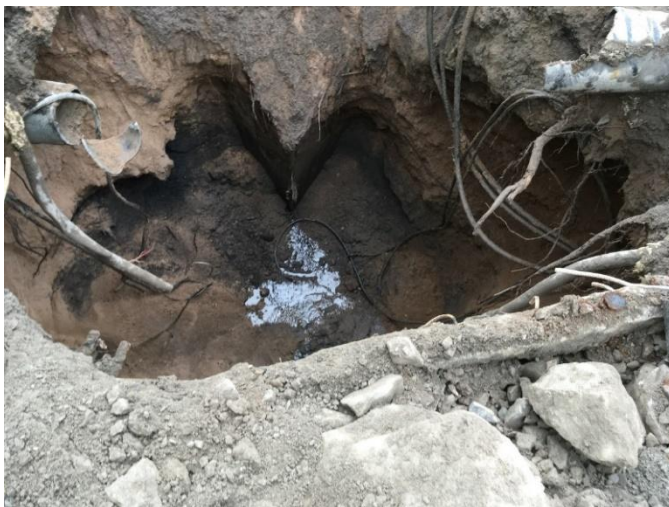
Figur 4-7 Provgrop 1w2, oljepåverkat vatten och gråsvart sand syns i gropen
