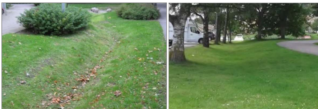
Figur 12. Exempel på grönt dike inom bostadsområde, till vänster brantare slänt och till höger svackdike.
