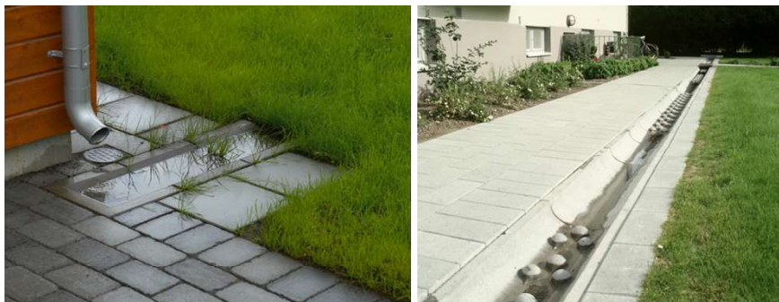
Figur 16. Vattenutkastare och dagvattenrännor ( www.steriks.se ).
