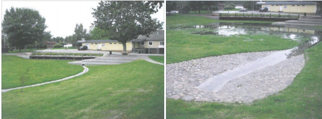
Figur 10. Öppet fördröjningsmagasin, tomt till vänster och med vattenspiegel till höger (Publikation P105).
