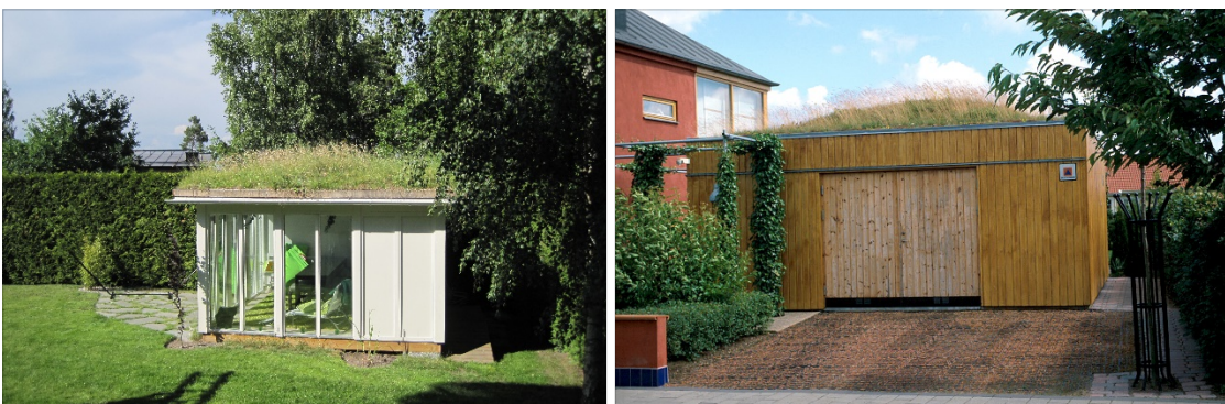
Figur 6. Sedumtak-ört-grästak på uterum och garage. Bilder hämtad från www.vegtech.se .
