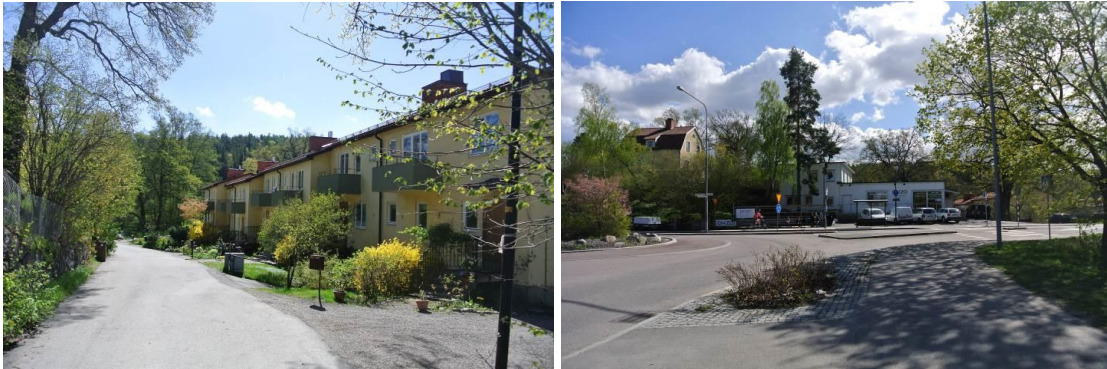
Fotot till vänster: Radhusområdet väster om fastigheten (vy mot söder). Fotot till höger: Den befintliga byggnadens exponerade läge.
