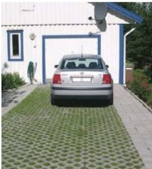
Figur 12 – Exempel på betonghålsten vilket lämpligt på planerade parkeringsplatser
