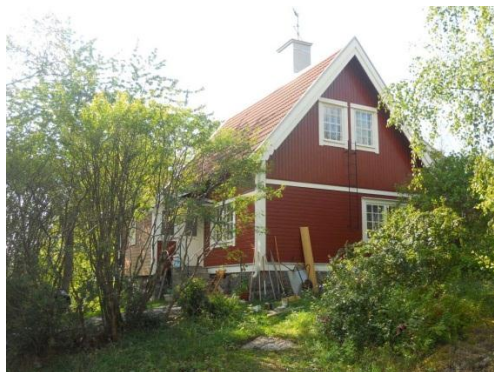
Vaktmästarbostaden strax norr om huvudbyggnaden. (Byggnad nummer 7)
