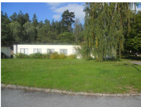
Förlägningsbyggnaden norr om gästhemmet. (Byggnad nummer 10)
