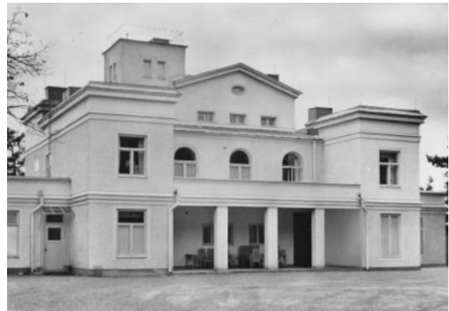
Huvudbyggnad före 60-talets ombyggnad.
